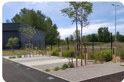
Parking permettant de tester différents types de revêtements perméables. Crédit photo : Valence Romans Agglo
