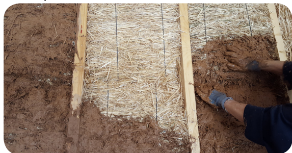
Caissons paille - Photo prise dans l'Atelier des charpentiers Mouysset frères. Copyright Bresson Schindlbeck Architectes
