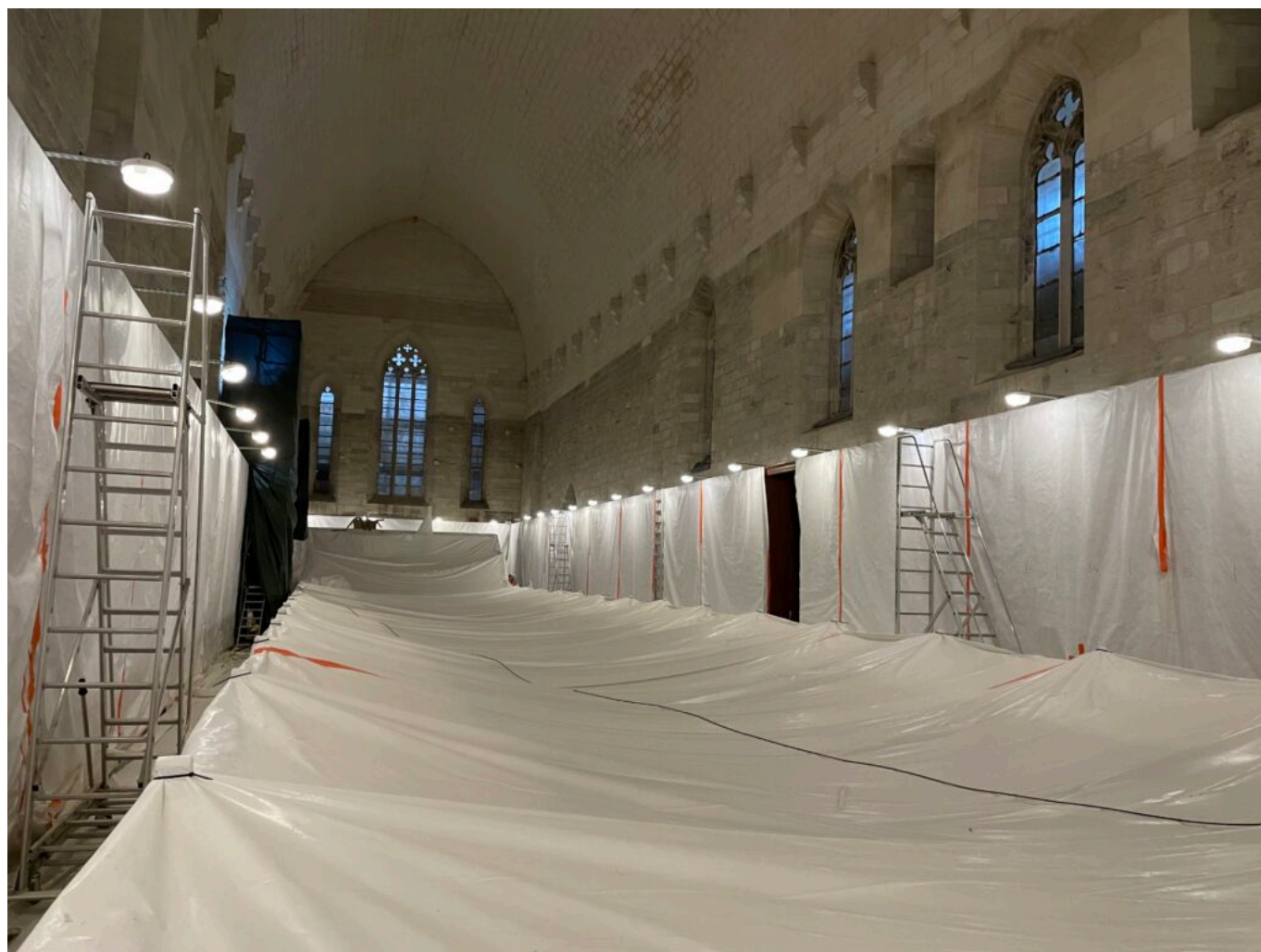
La Chapelle Benoit XII entièrement bâchée Copyright Mireille Hurlin
