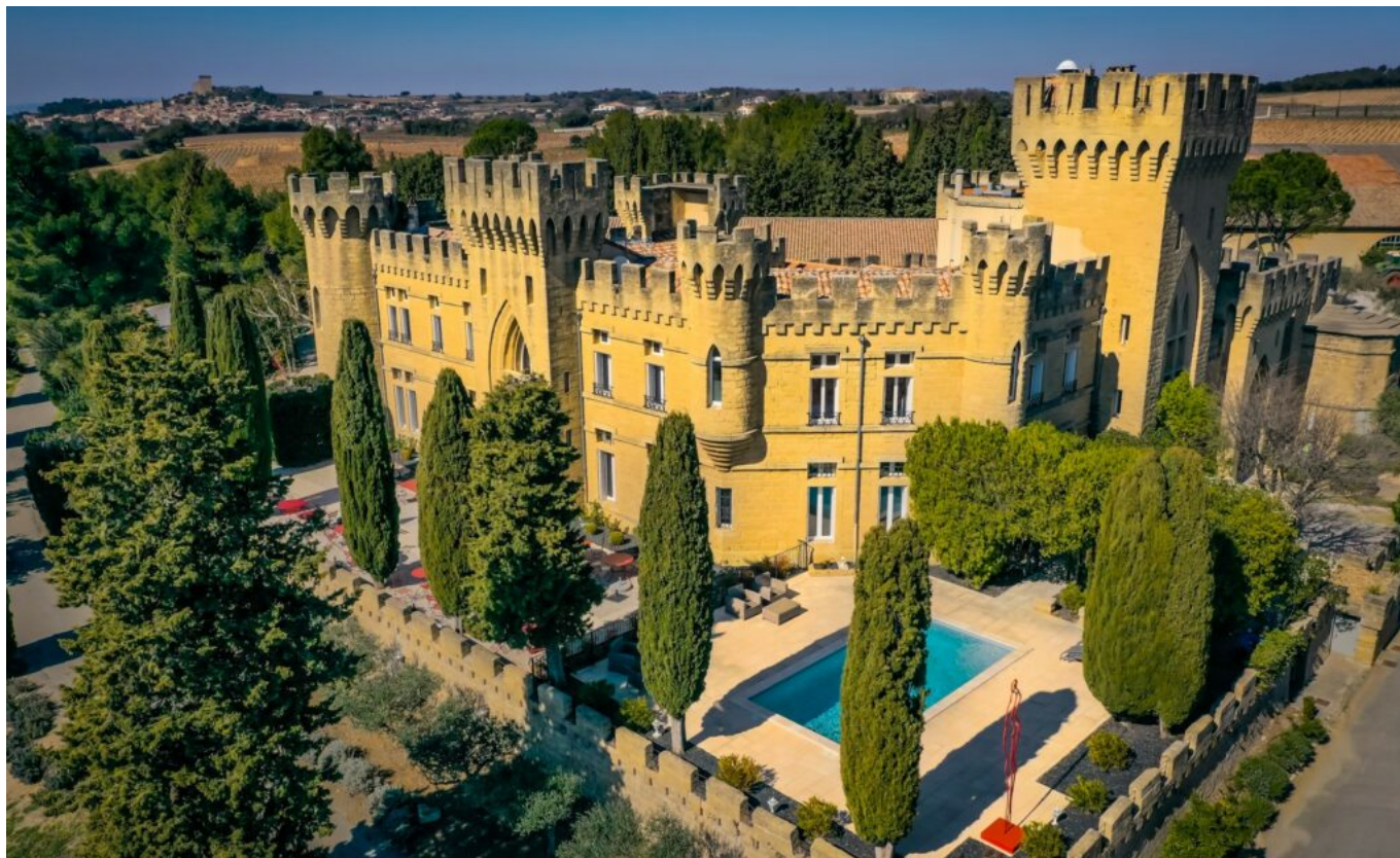
Le Château des Fines Roches
