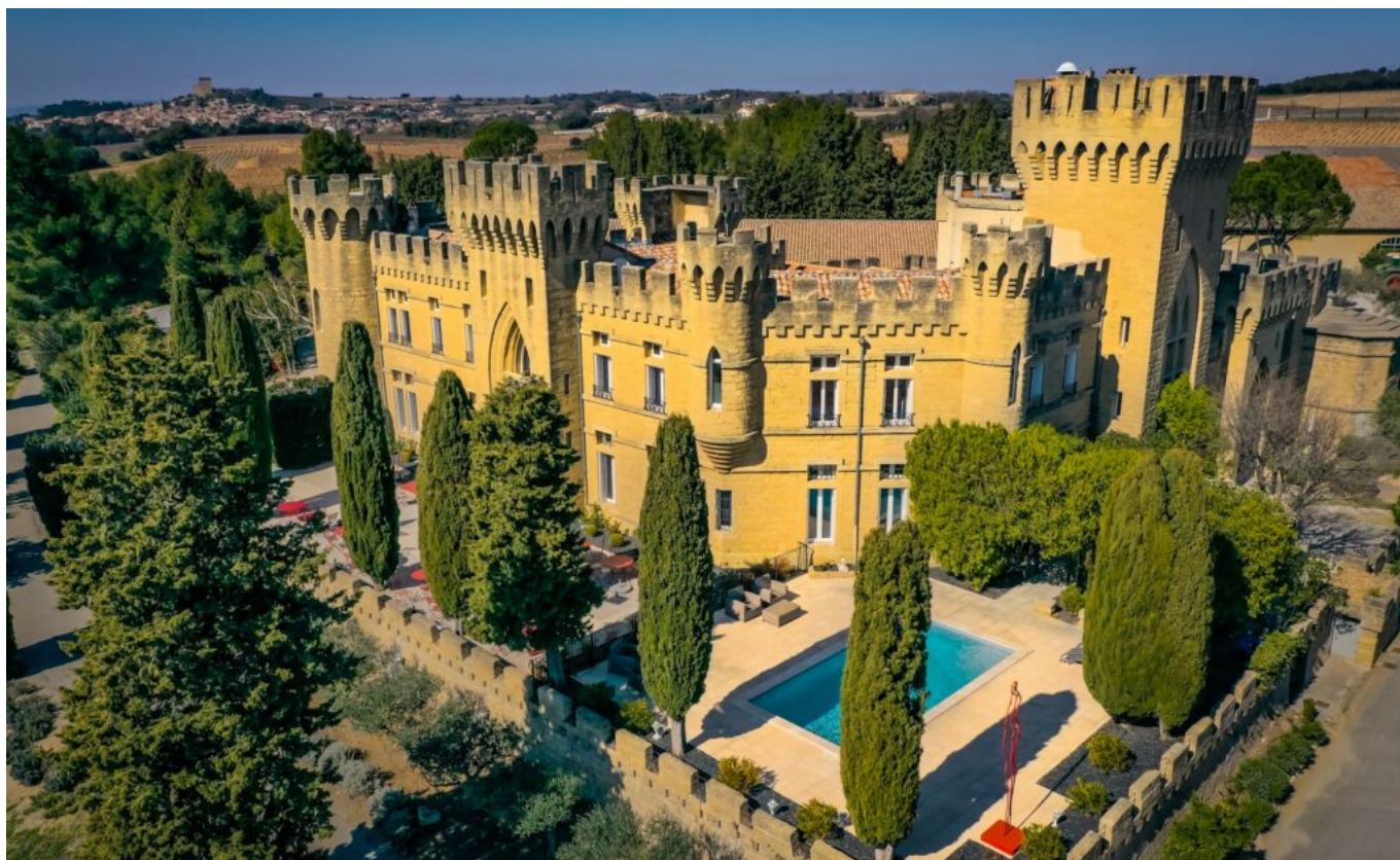
Le Château des Fines Roches
