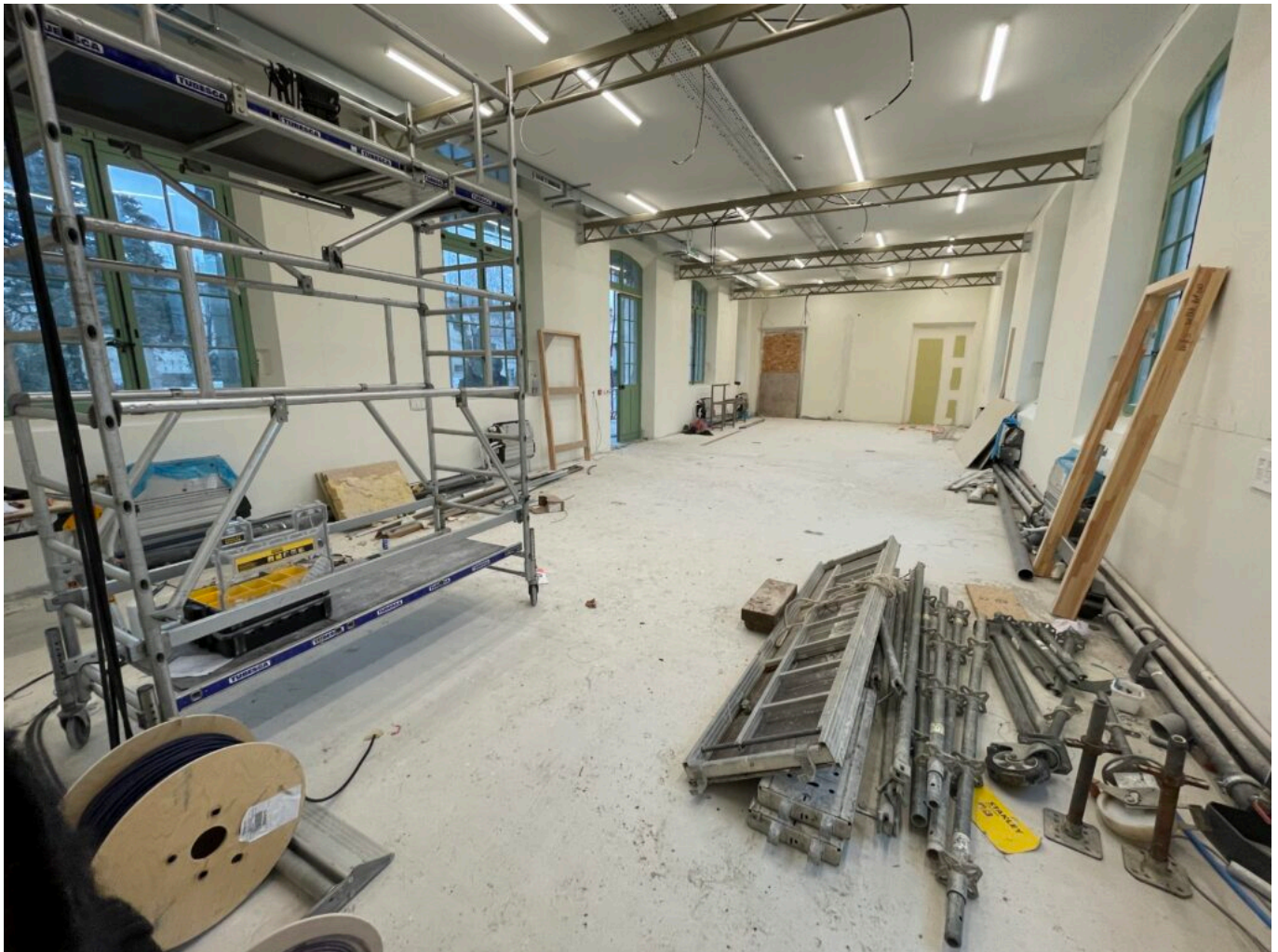
Une des quatre galeries de 110m2 en cours de finition Copyright MMH
