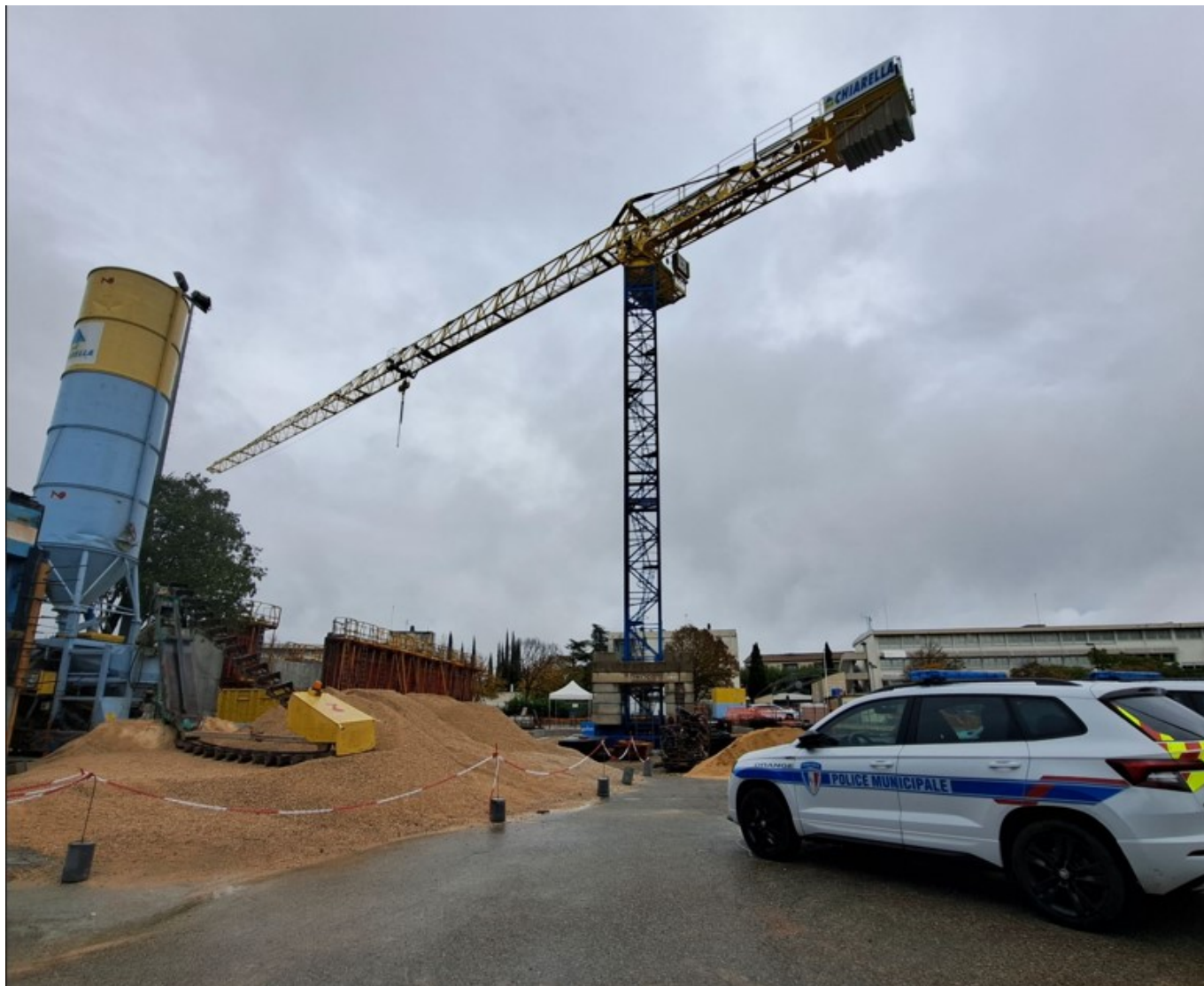
Le chantier du futur poste de la police municipale d'Orange. DR
