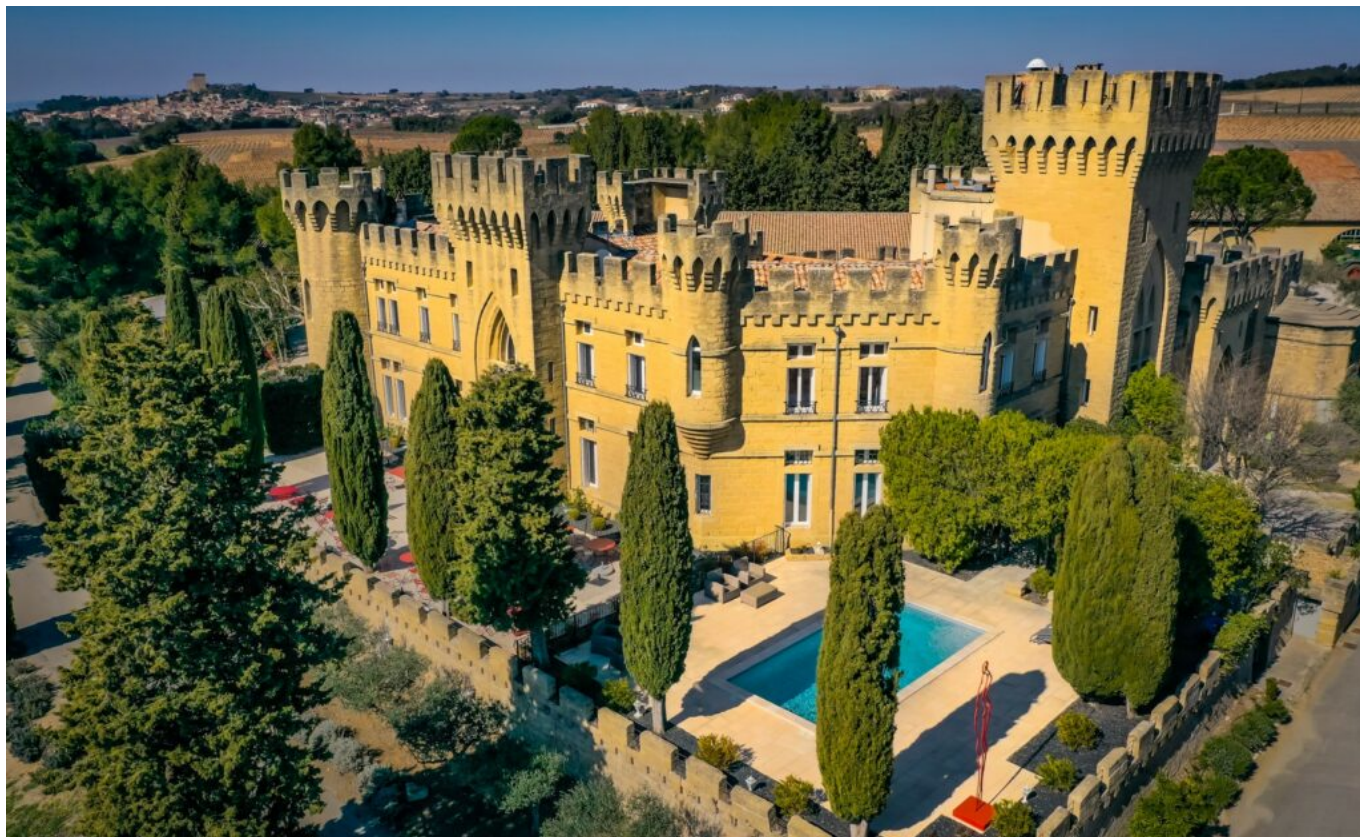
Le Château des Fines Roches
