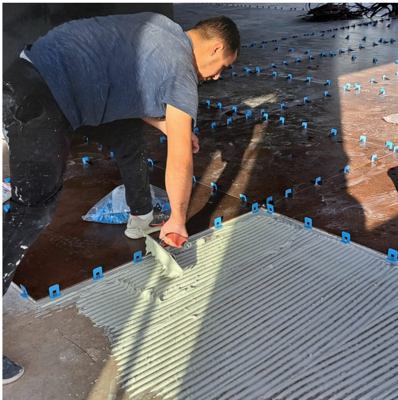
Pose du carrelage ©AB/L'Echo du Mardi
