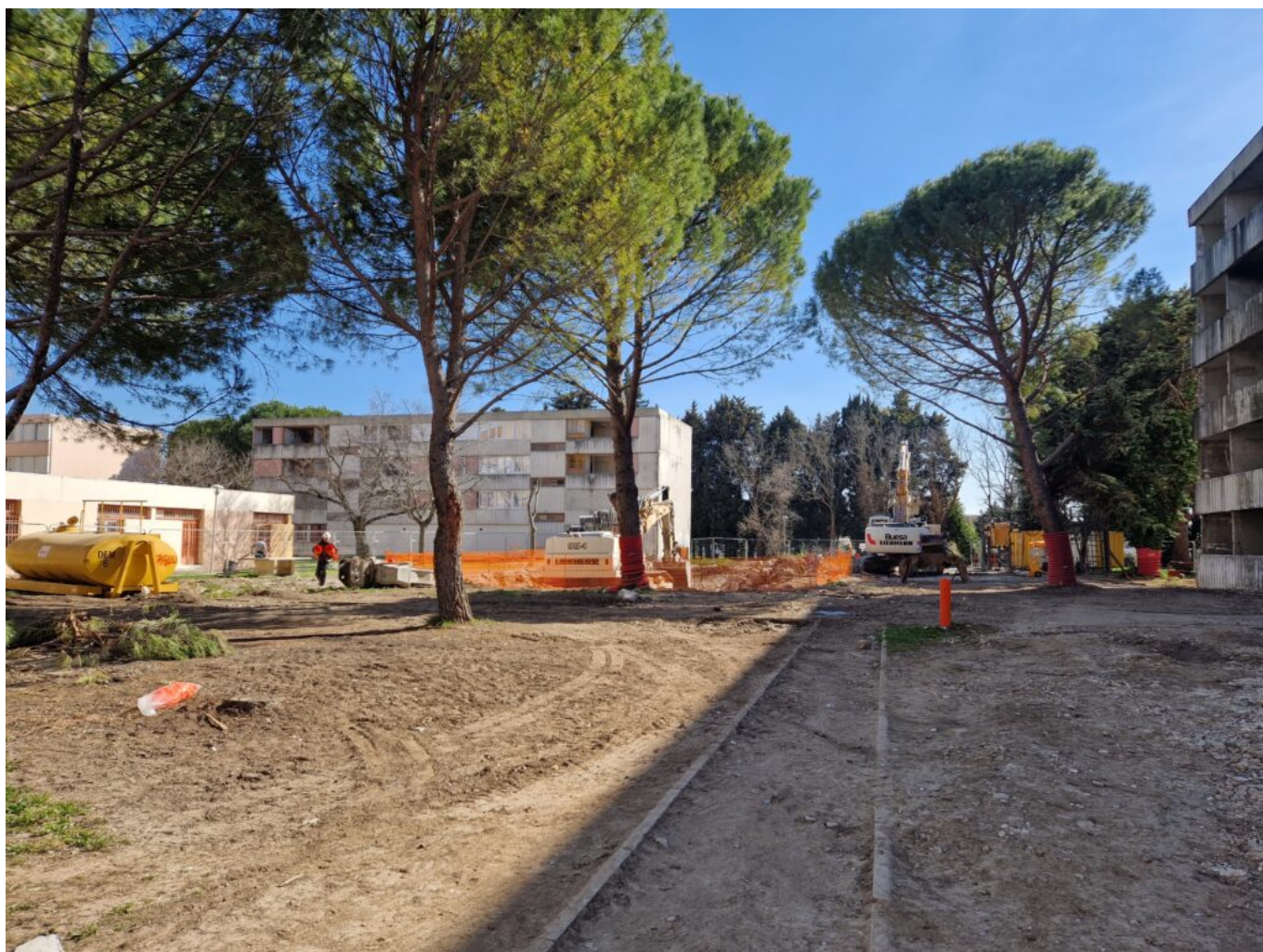
Le chantier en cours
