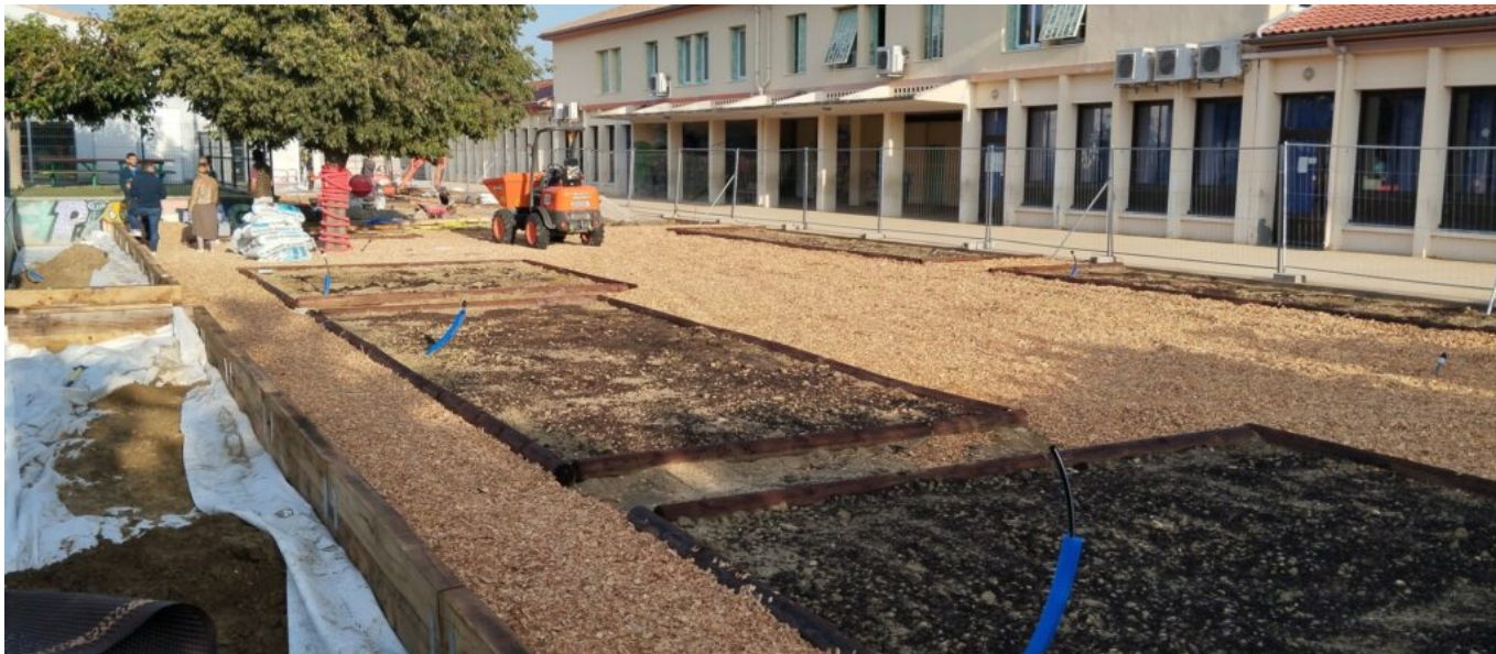
Le chantier de désimperméabilisation de l'école. Crédit : Piolenc/DR
