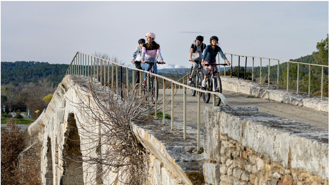
Sur le Pont Julien et la Véloroute du Calavon ©Cyril Cortez
