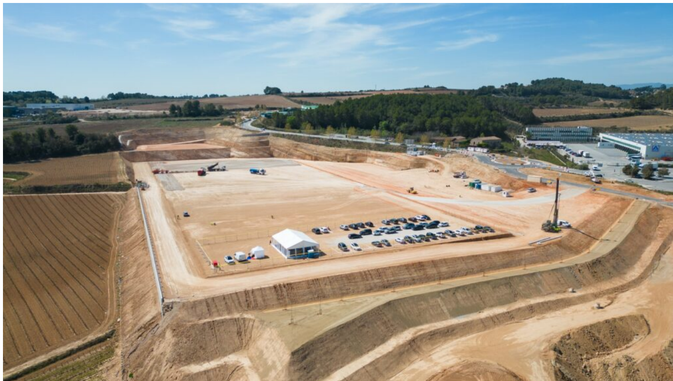
Site du futur ensemble logistique pour GLP à Barcelone © GSE
