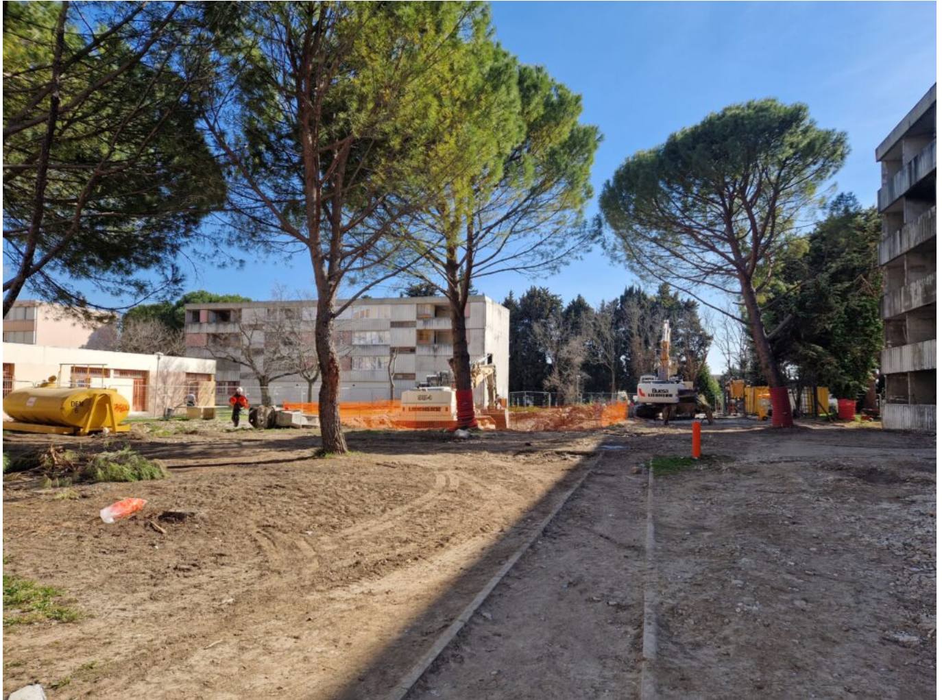
Le chantier en cours
