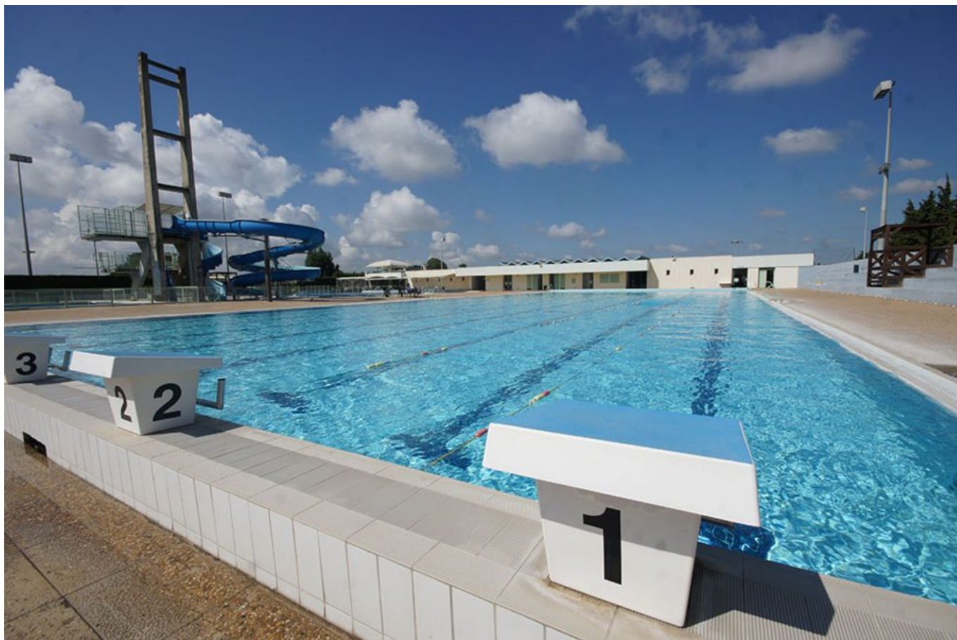
Photo: stade nautique de Carpentras
