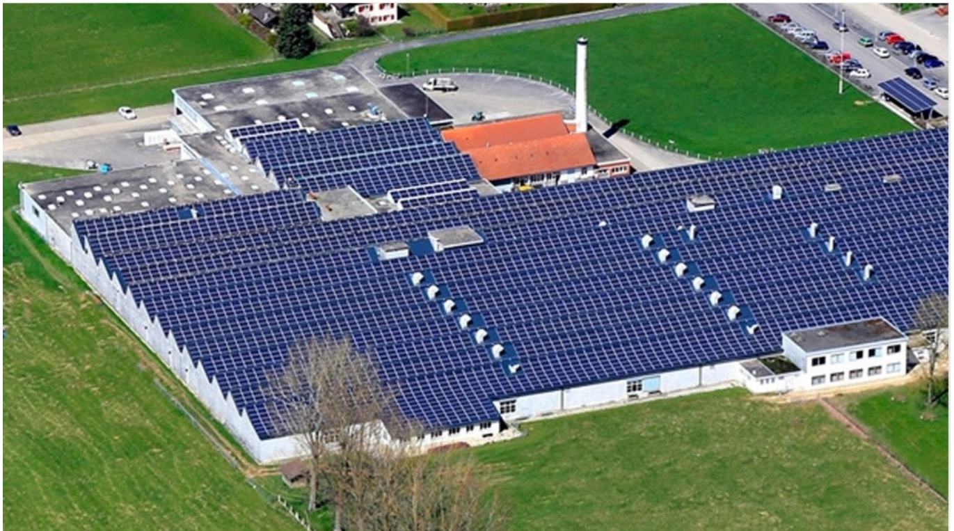
Be Energy Suisse Occidentale DR Be Energy
