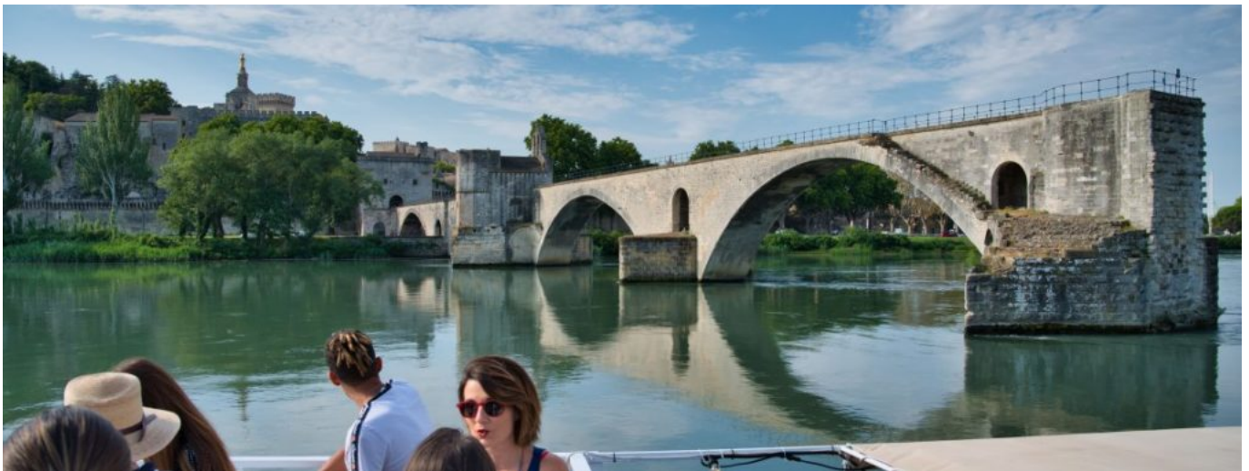
Photo: Grands bateaux de Provence
