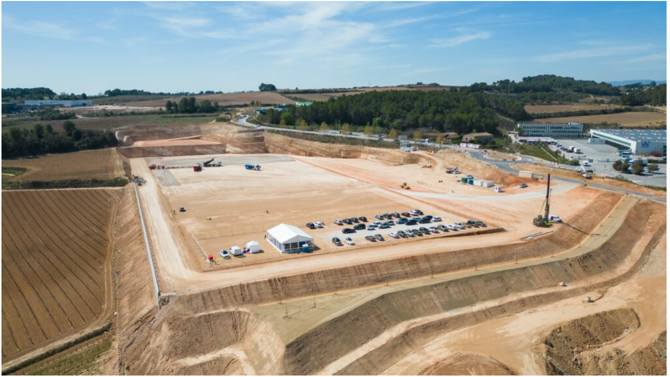
Site du futur ensemble logistique pour GLP à Barcelone © GSE
