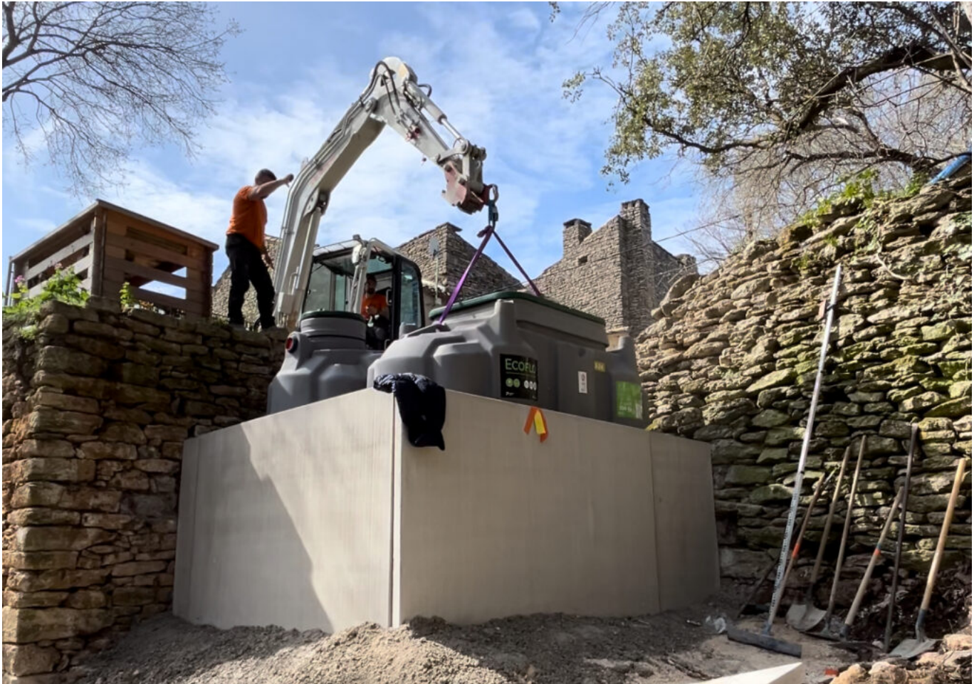
Installation d'une fausse septique Copyright GM terrassement
