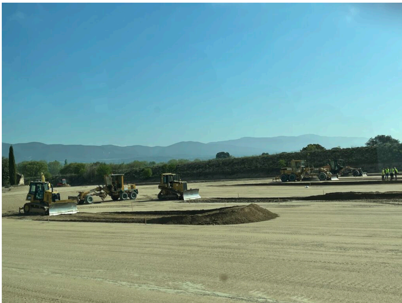
Exercices de terrassement
