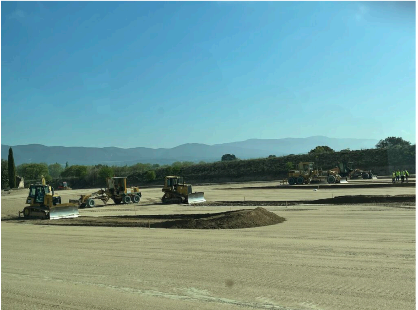
Exercices de terrassement
