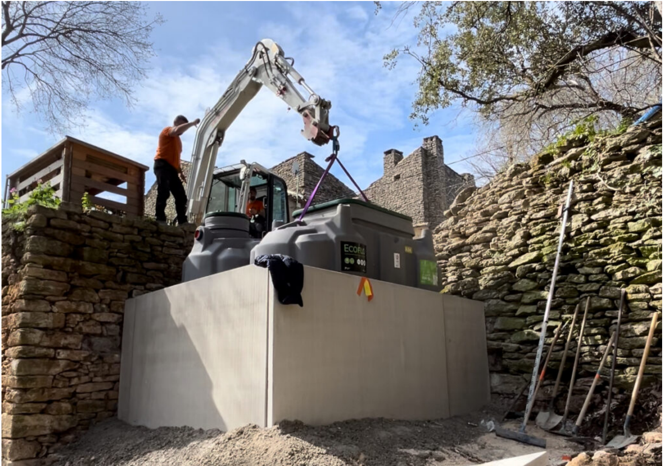
Installation d'une fausse septique Copyright GM terrassement
