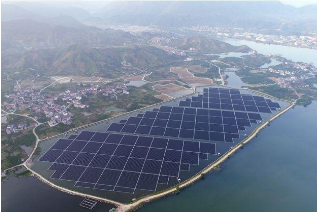
Centrale solaire flottante de Piolenc. DR
