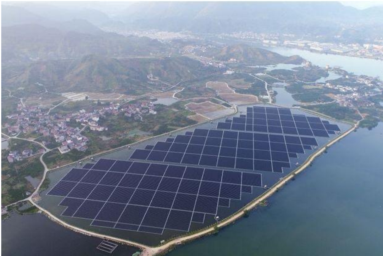
Centrale solaire flottante de Piolenc. DR
