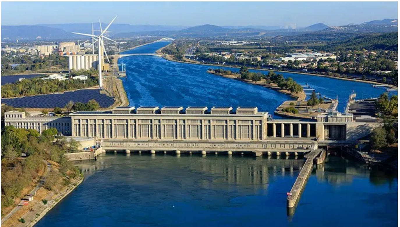
Centrale hydroélectrique de Bollène . ©CNR Bollène
