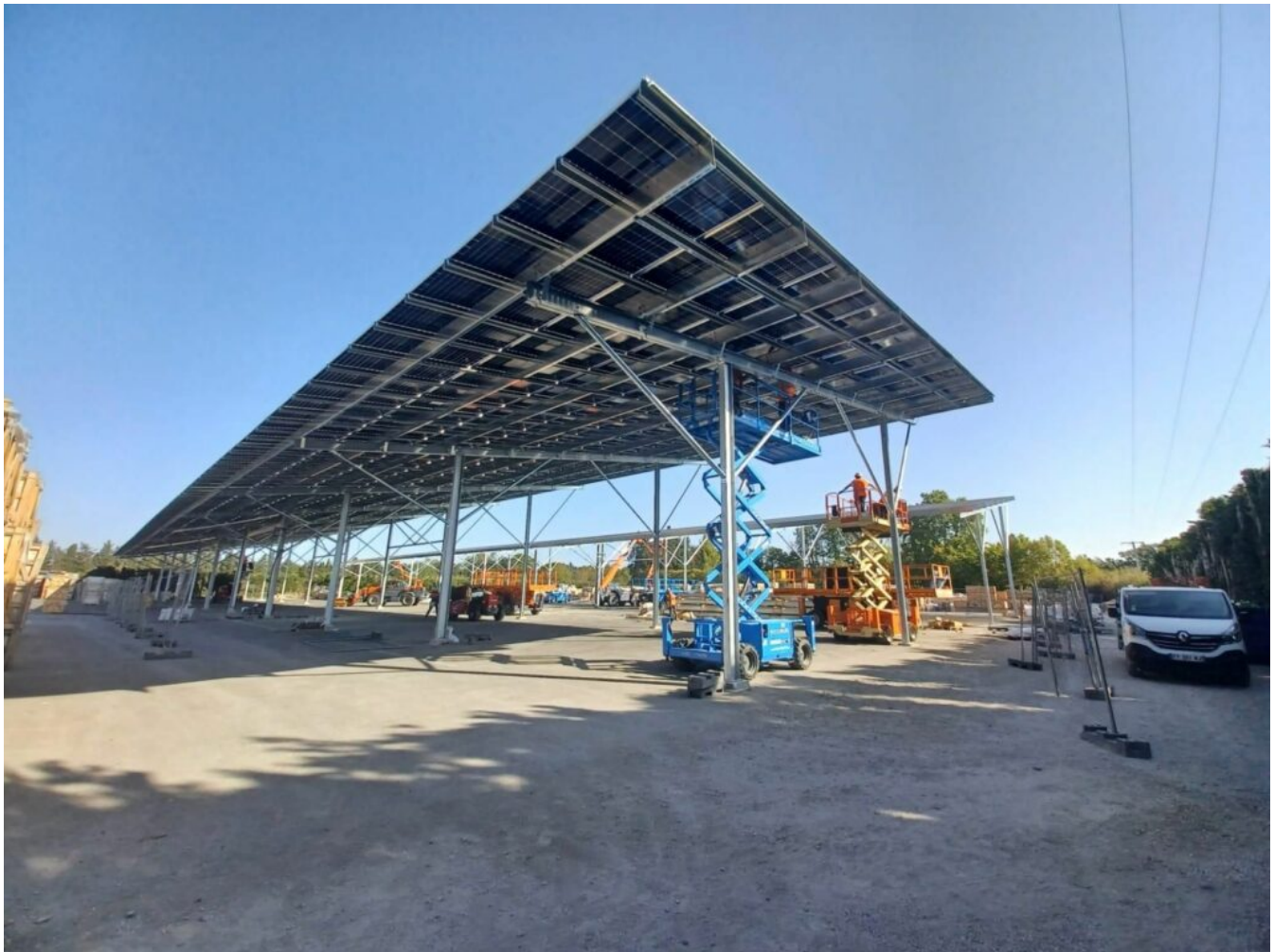
Chantier sur les zones de stockage de Natural Rock Distribution à Avignon. ©Melvan
