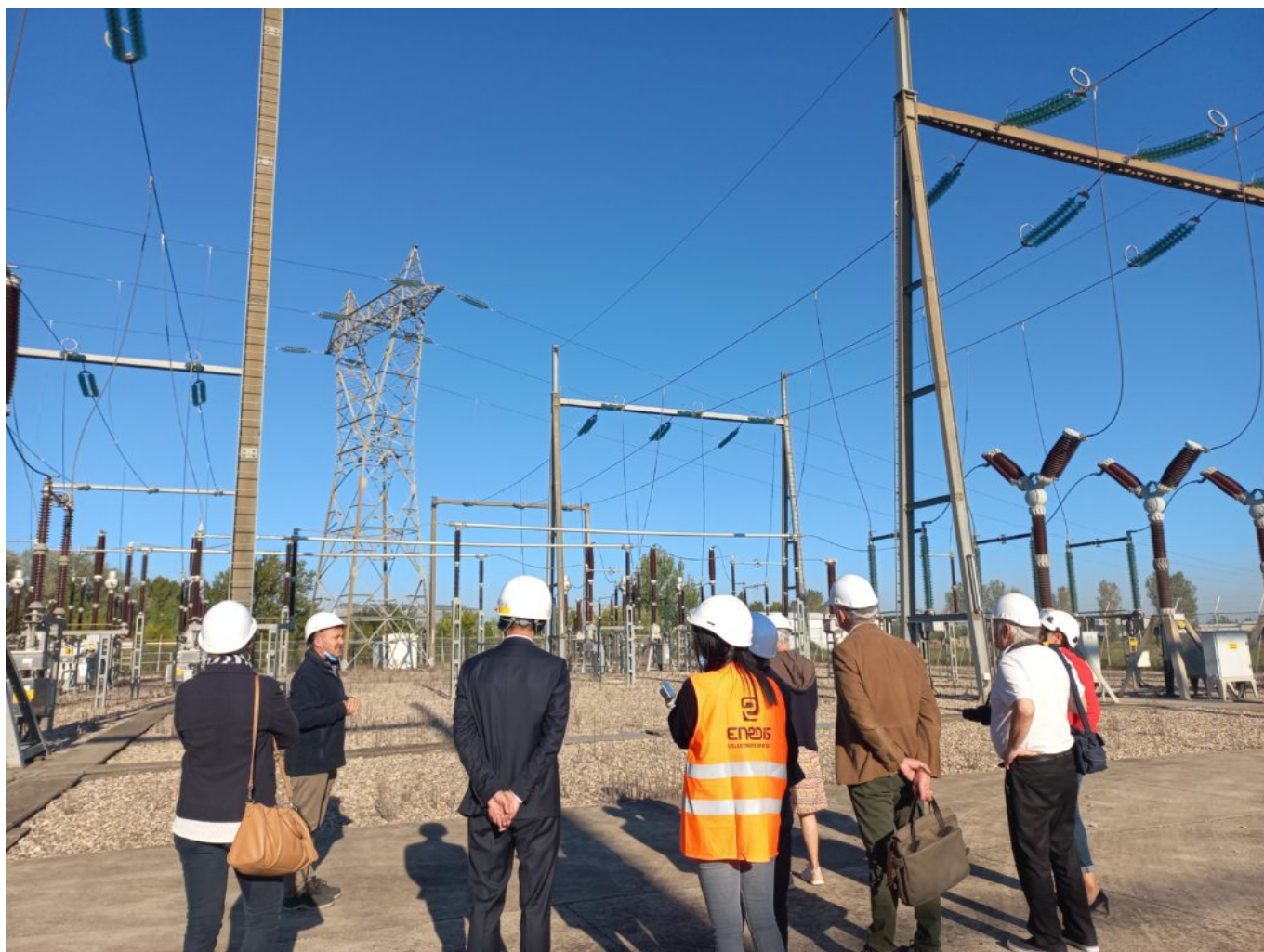
Visite de chantier. Crédit photo: Enedis
