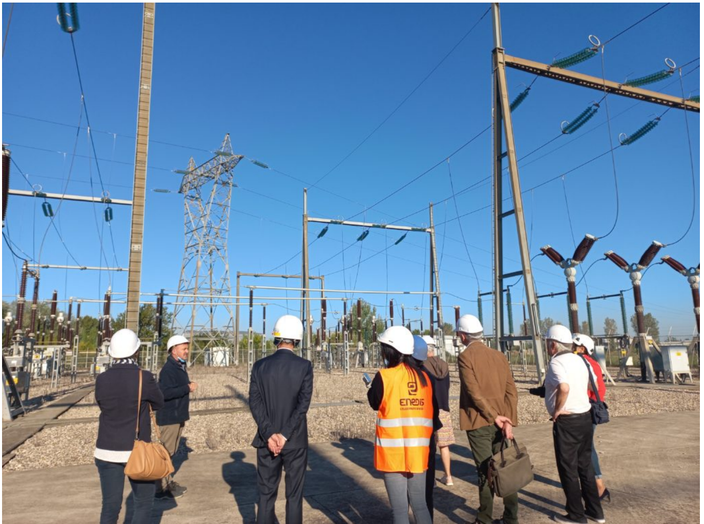
Visite de chantier. Crédit photo: Enedis
