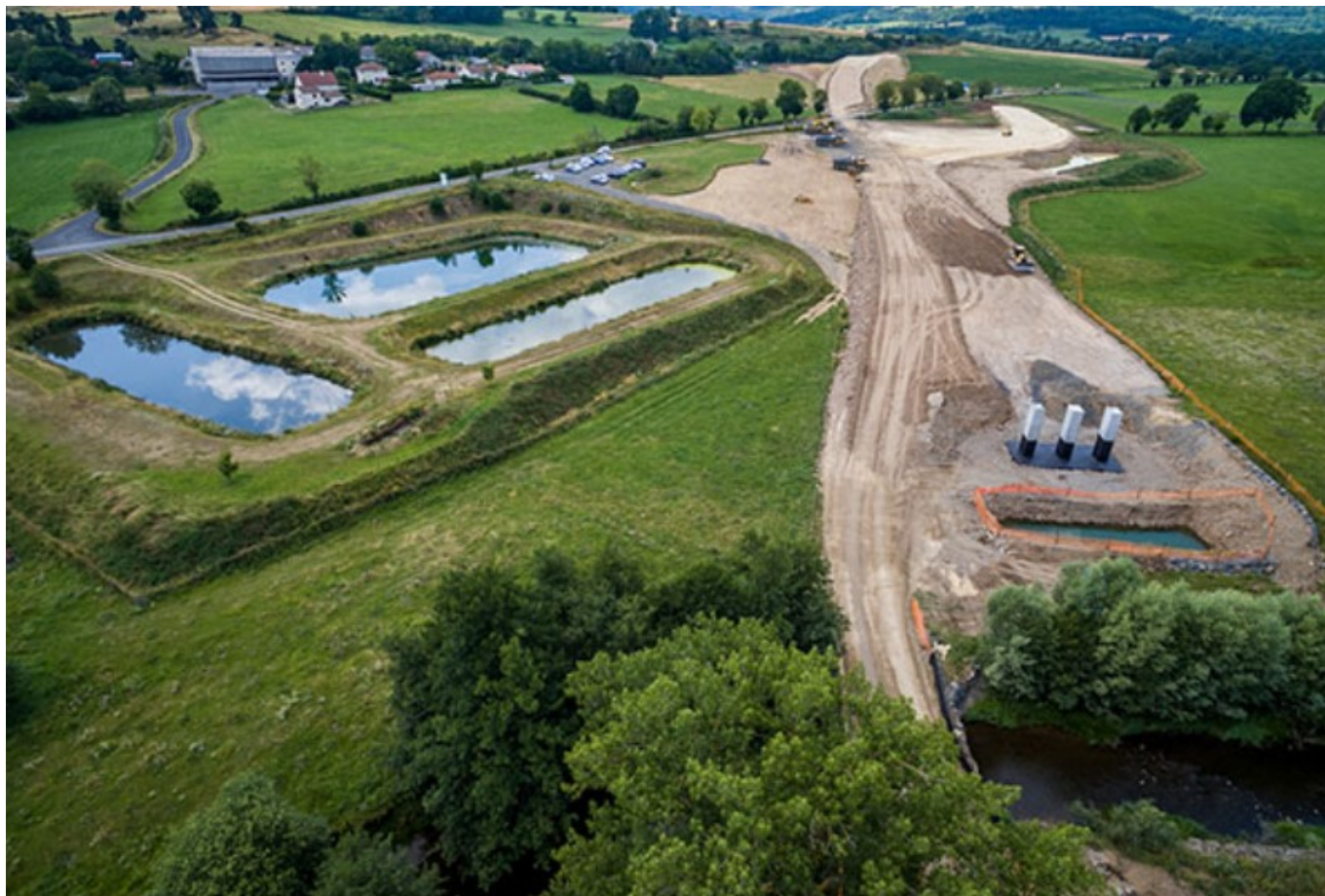
Travaux NGE DR
