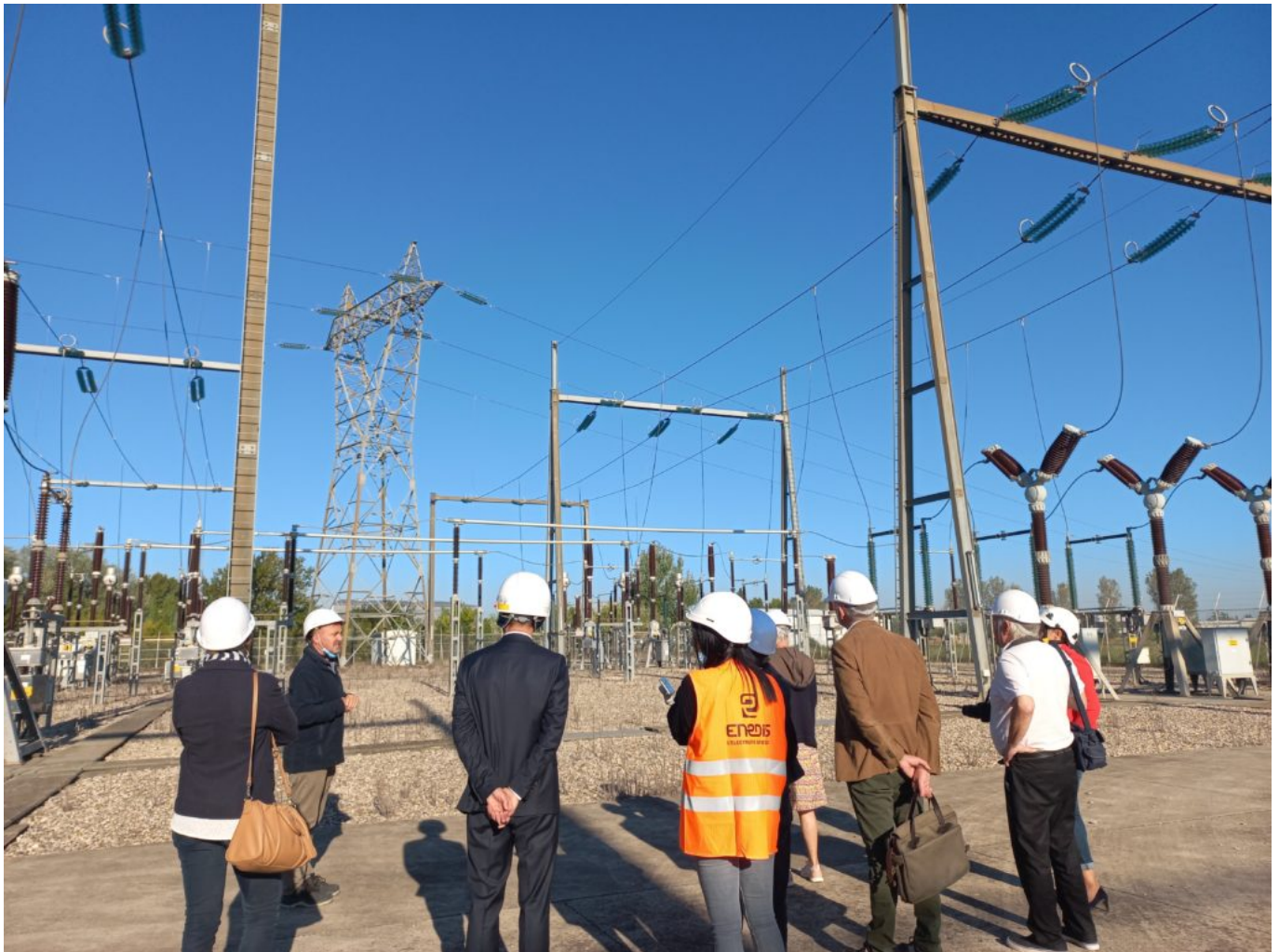
Visite de chantier. Crédit photo: Enedis
