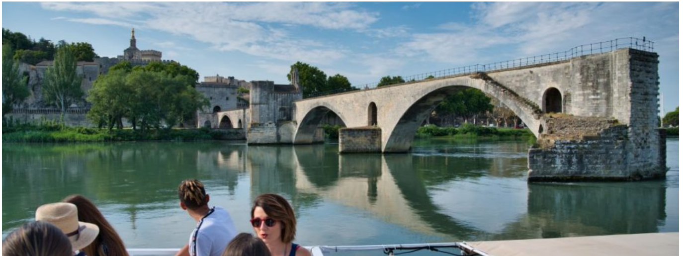
Photo: Grands bateaux de Provence
