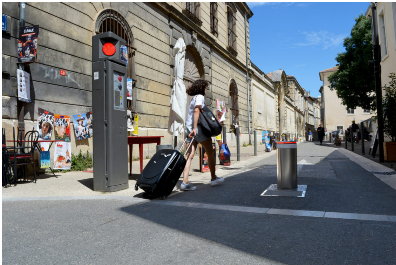
Systeme BES installé à Avignon
