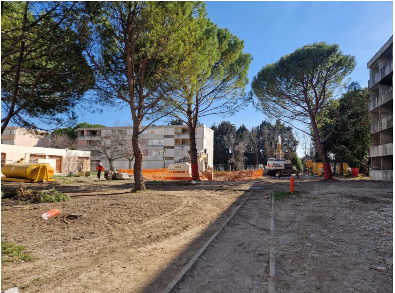
Le chantier en cours
