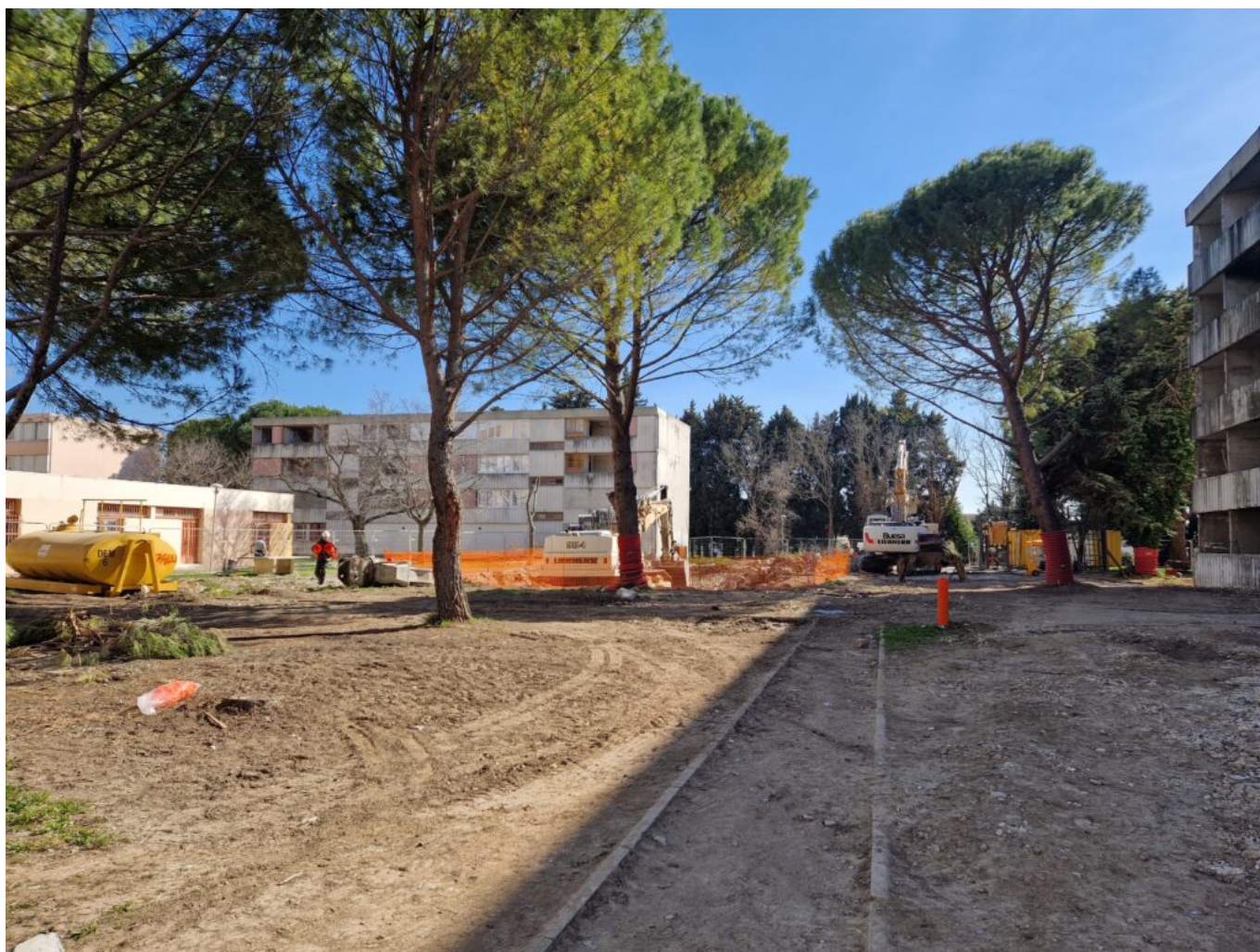
Le chantier en cours
