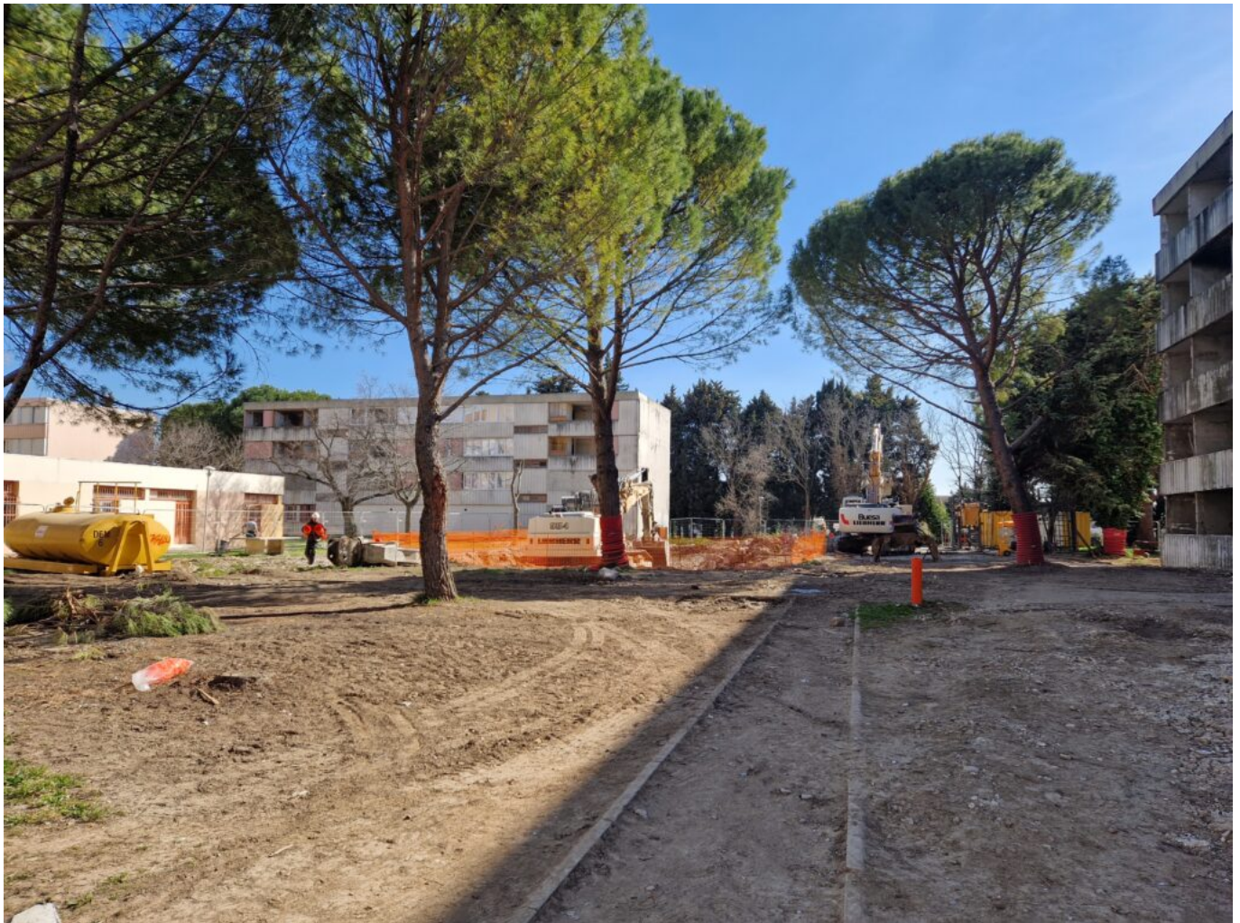
Le chantier en cours
