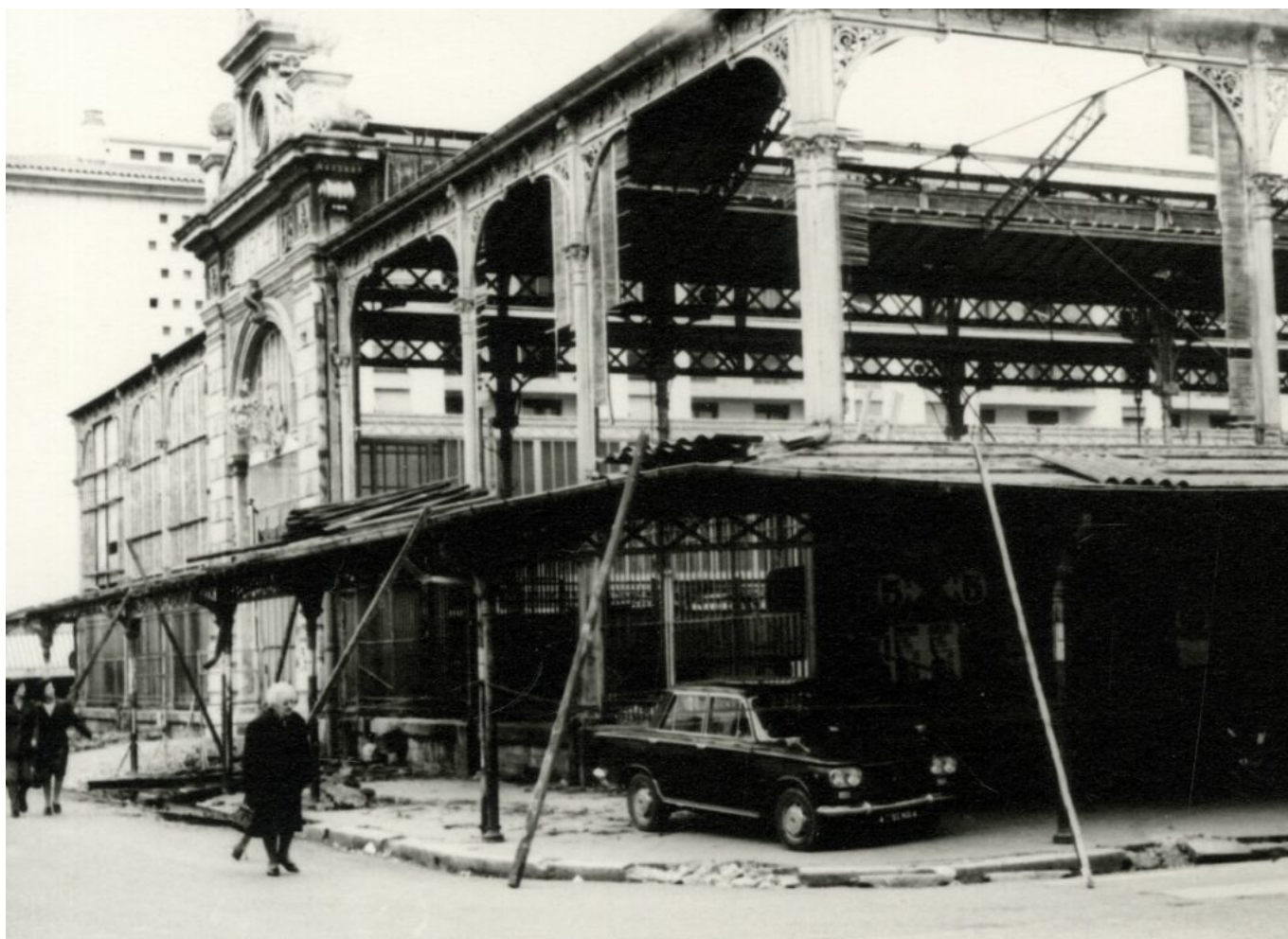
Les Halles en cours de démolition en 1972. Fond privé. Archives municipales. Anonyme. Photographie, 13X18
