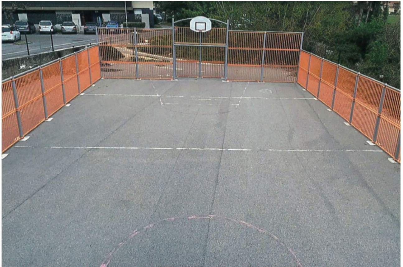
• Avant les travaux
