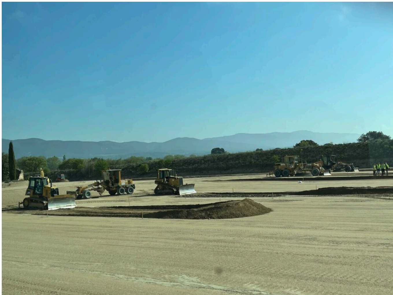
Exercices de terrassement
