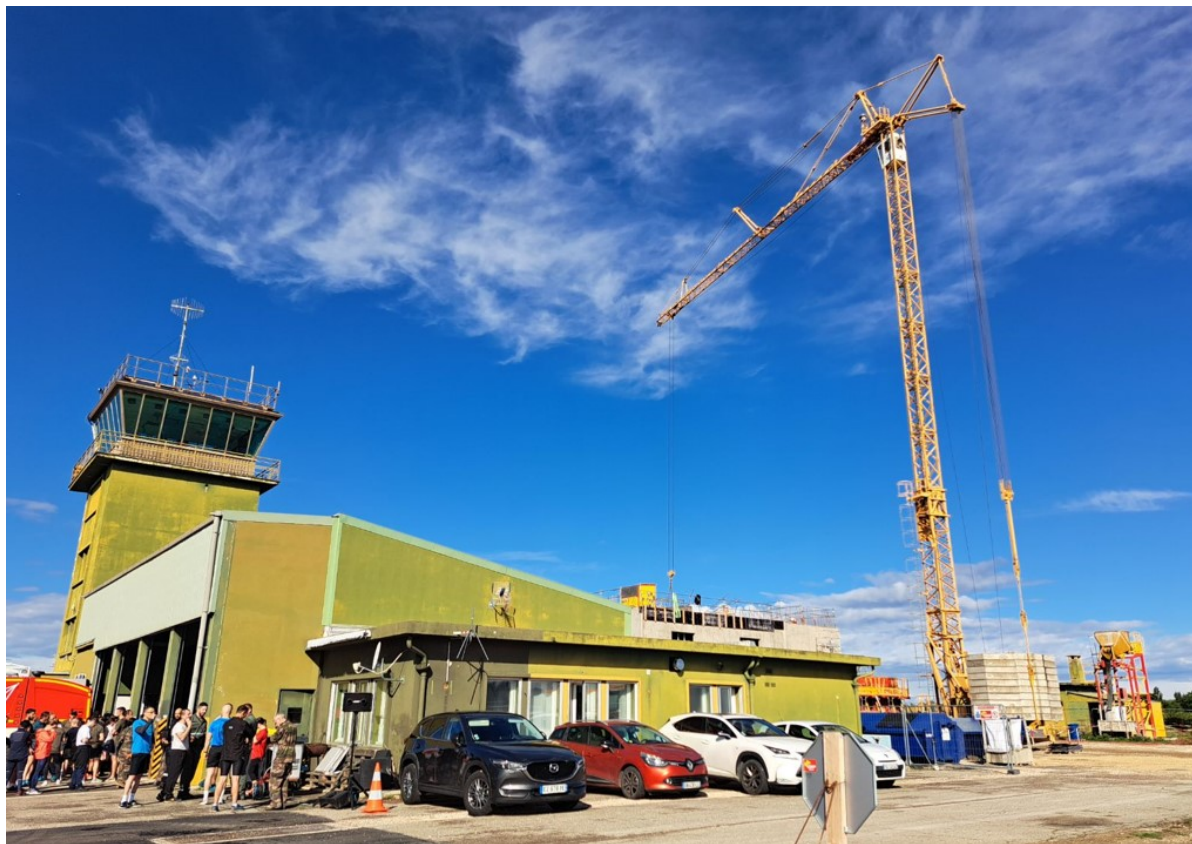
La future tour de contrôle en chantier à côté de l'ancienne.
