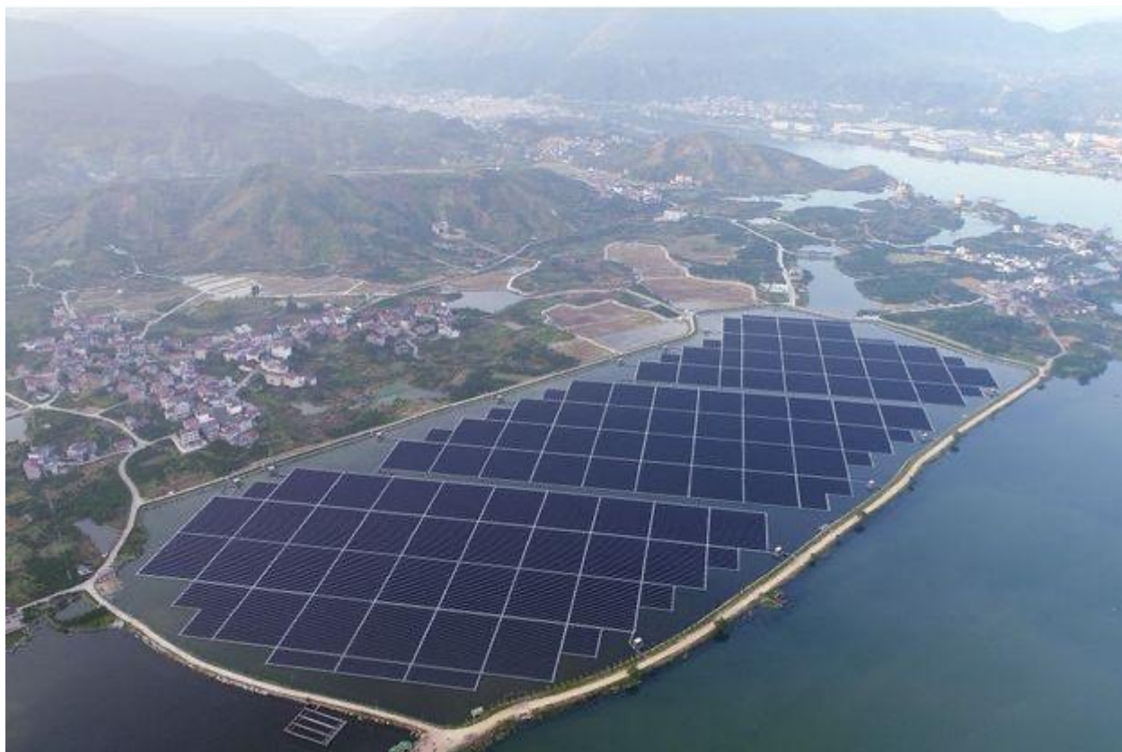
Centrale solaire flottante de Piolenc. DR
