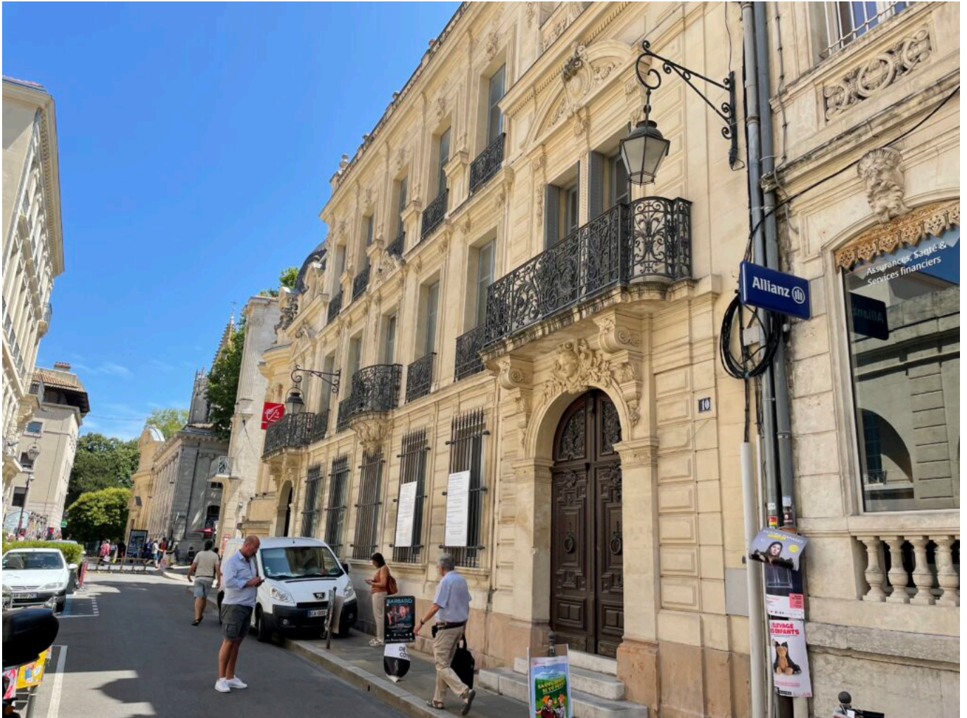
Vue actuelle de la rue copyright MH
