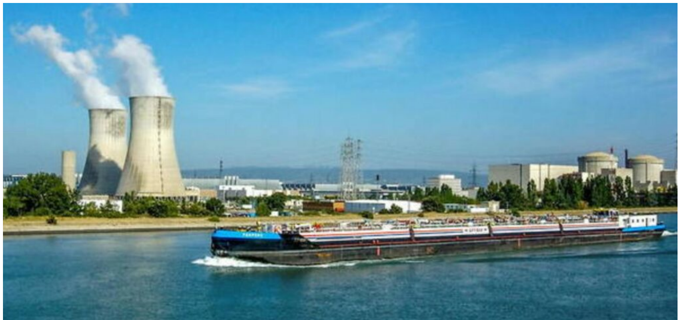
Centrale de Tricastin, image d'archive
