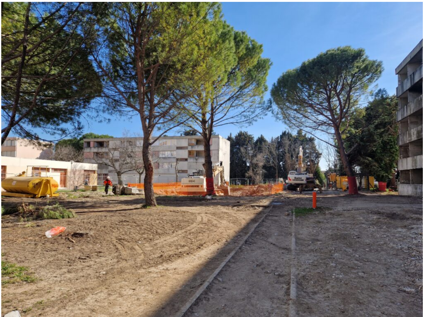
Le chantier en cours
