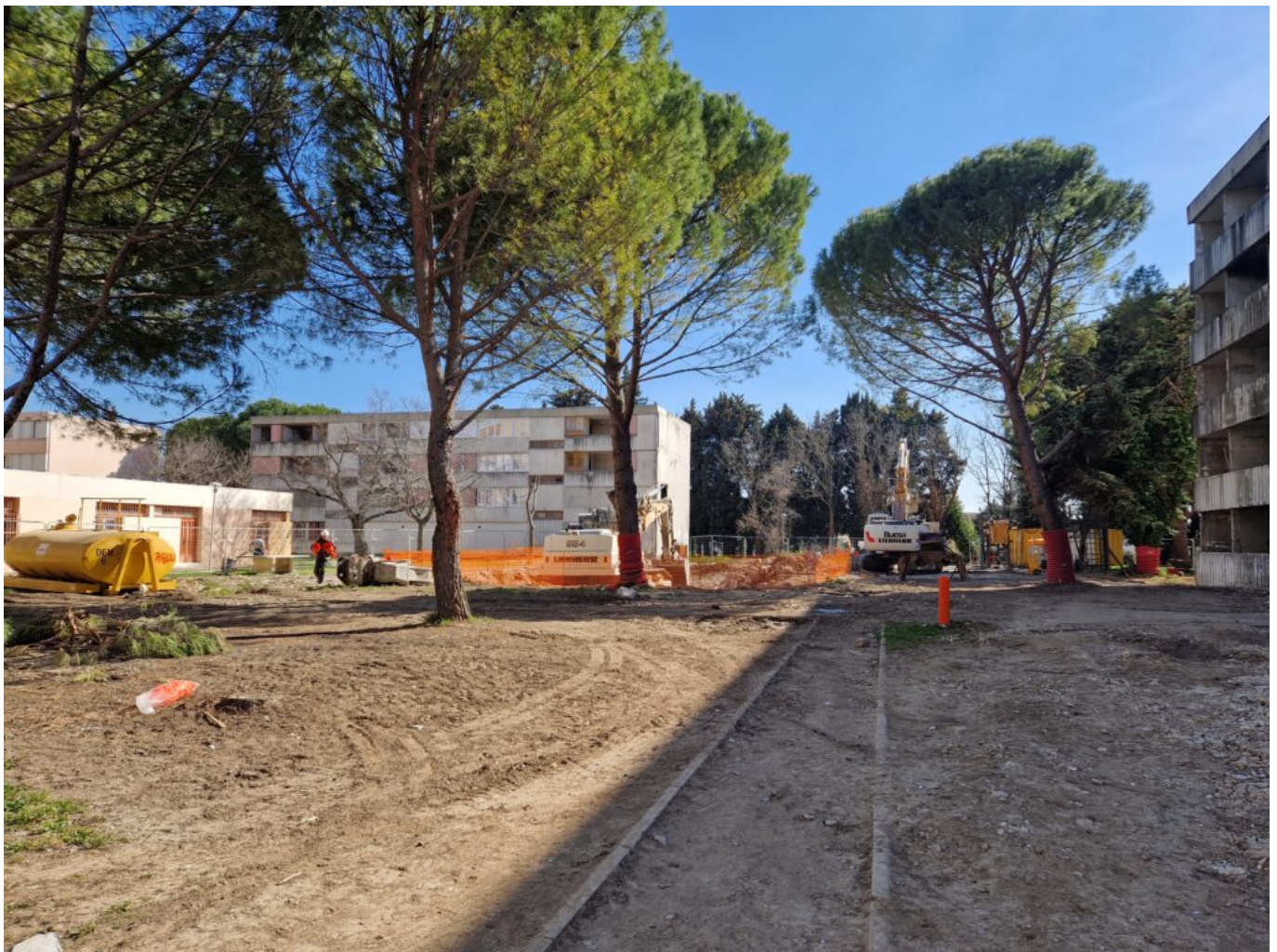
Le chantier en cours
