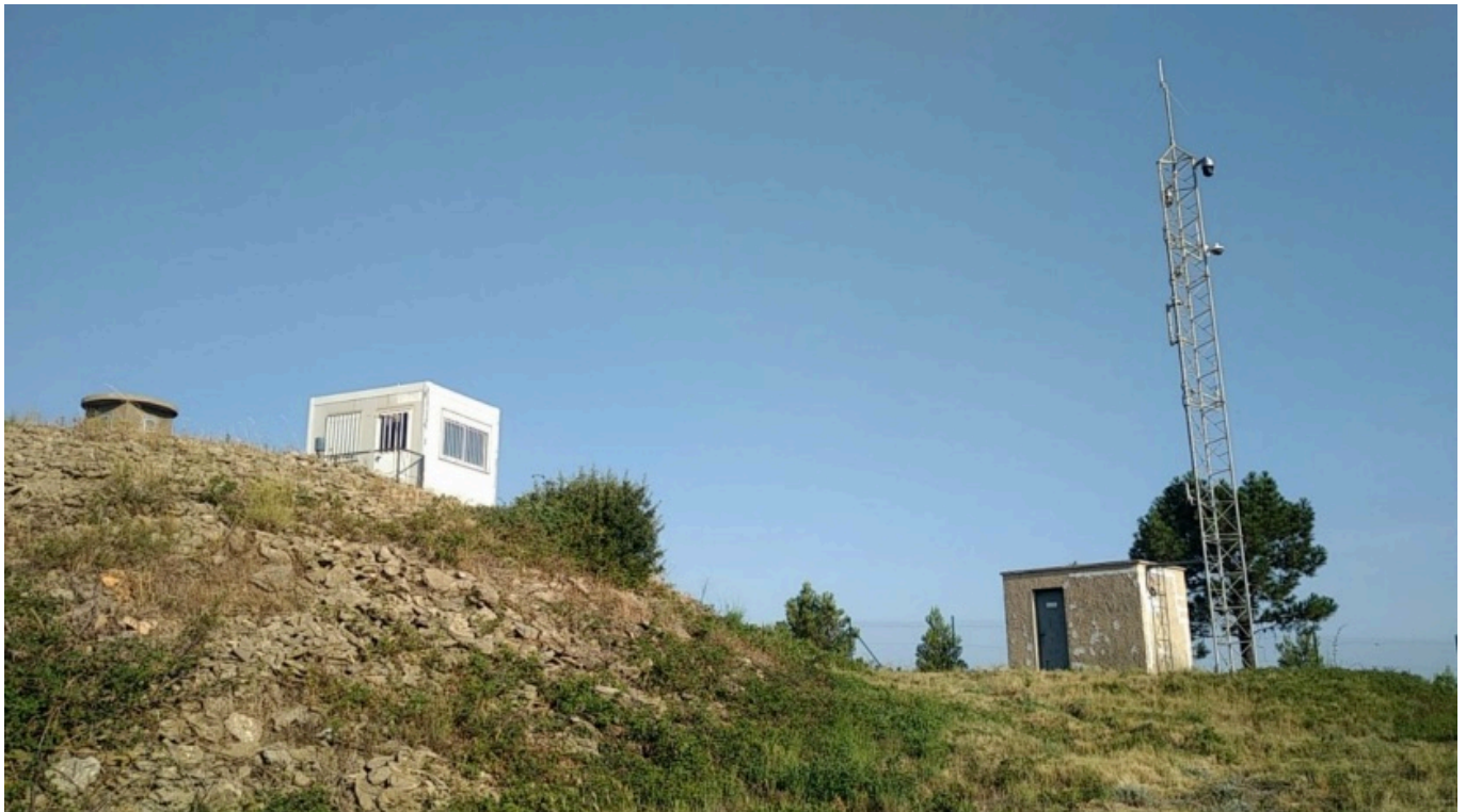
Exemple de caméra (à droite) installé au sein du département. ©SDIS 84
