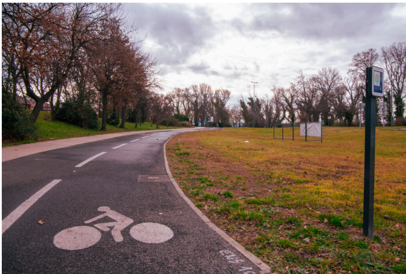
Travaux véloroutes Calavon-Cavaillon Copytight Stéphane Taufer
