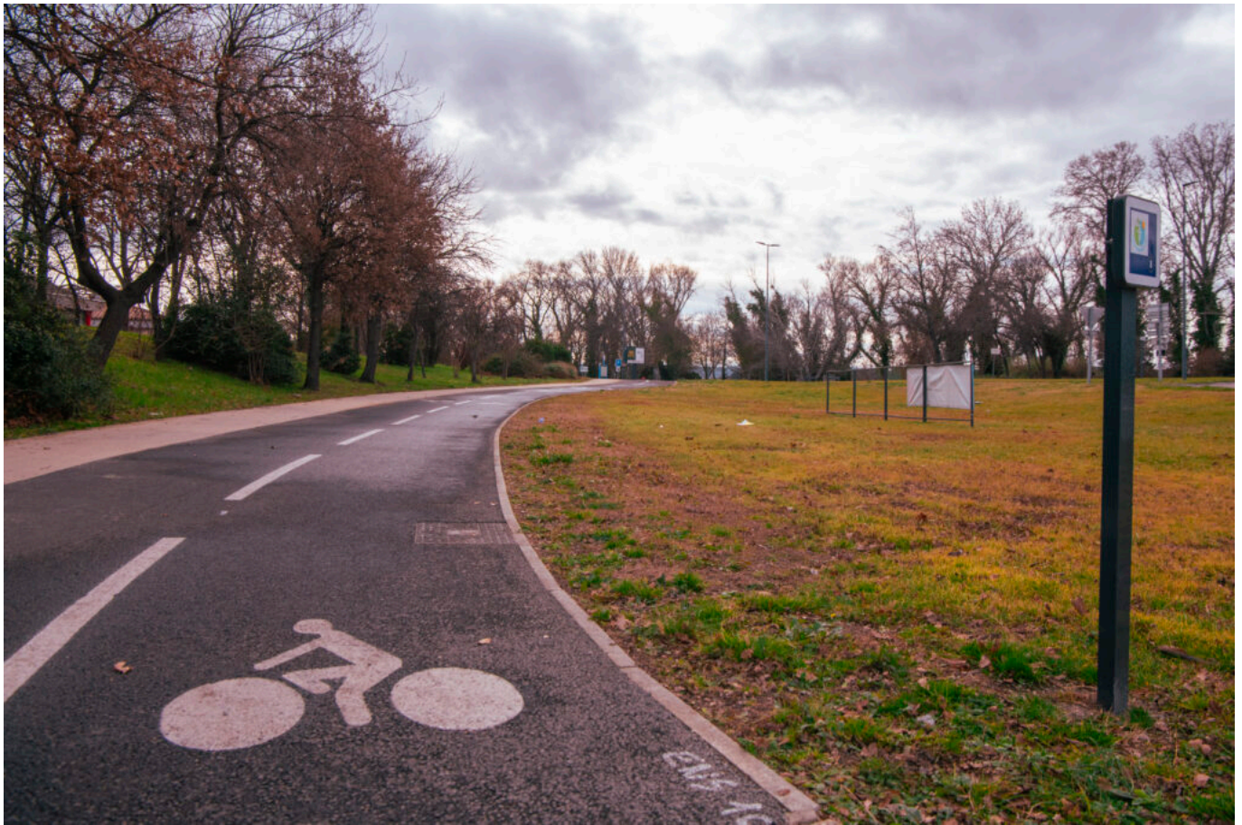
Travaux véloroutes Calavon-Cavaillon Copytight Stéphane Taufer
