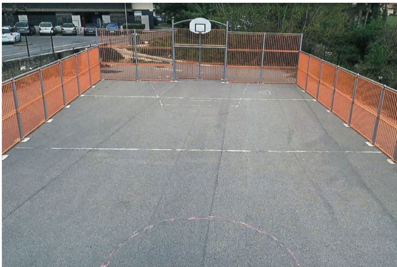
• Avant les travaux
