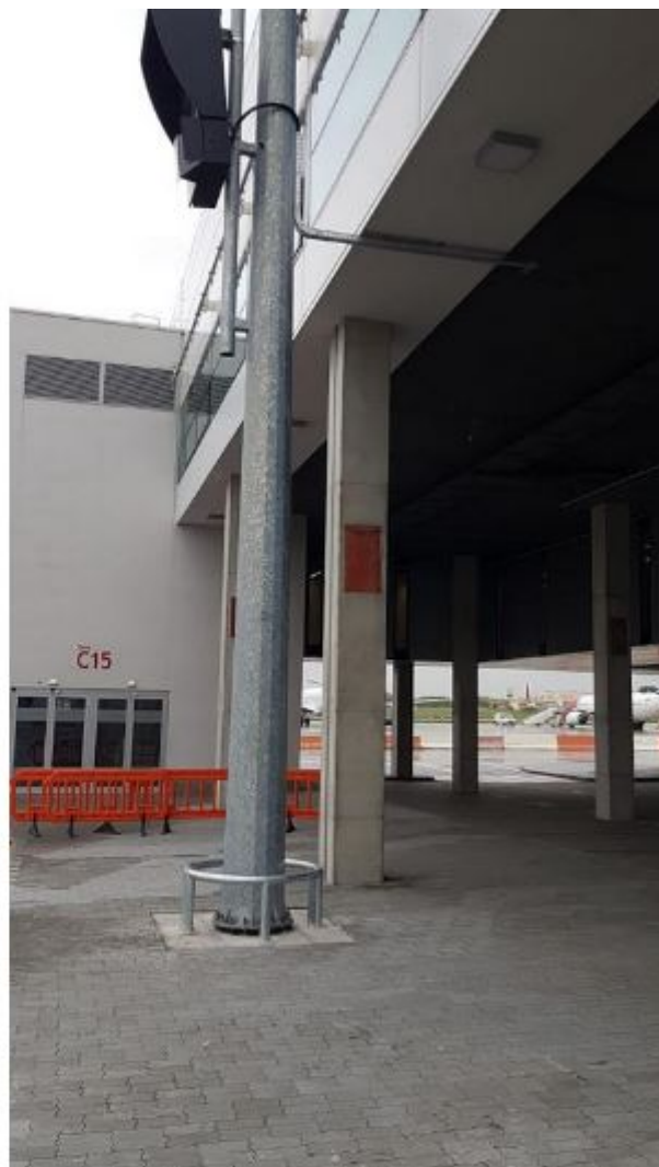
Budapest Hongrie : poteaux pour systèmes de guidage visuel d'amarrage aéroportuaire. Crédit photos: Technimast
