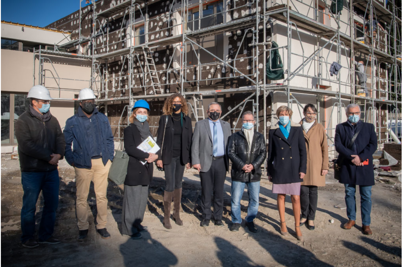
Visite de chantier. Crédit photo : Grand Avignon
