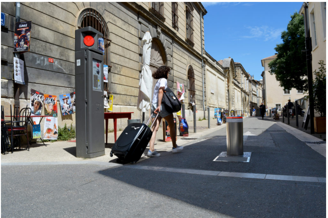
Système BES installé à Avignon
