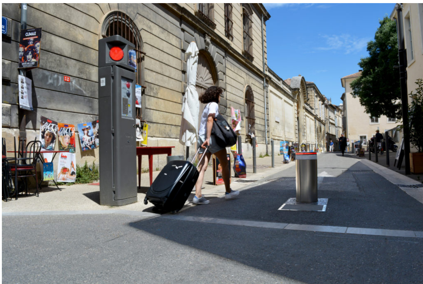
Système BES installé à Avignon
