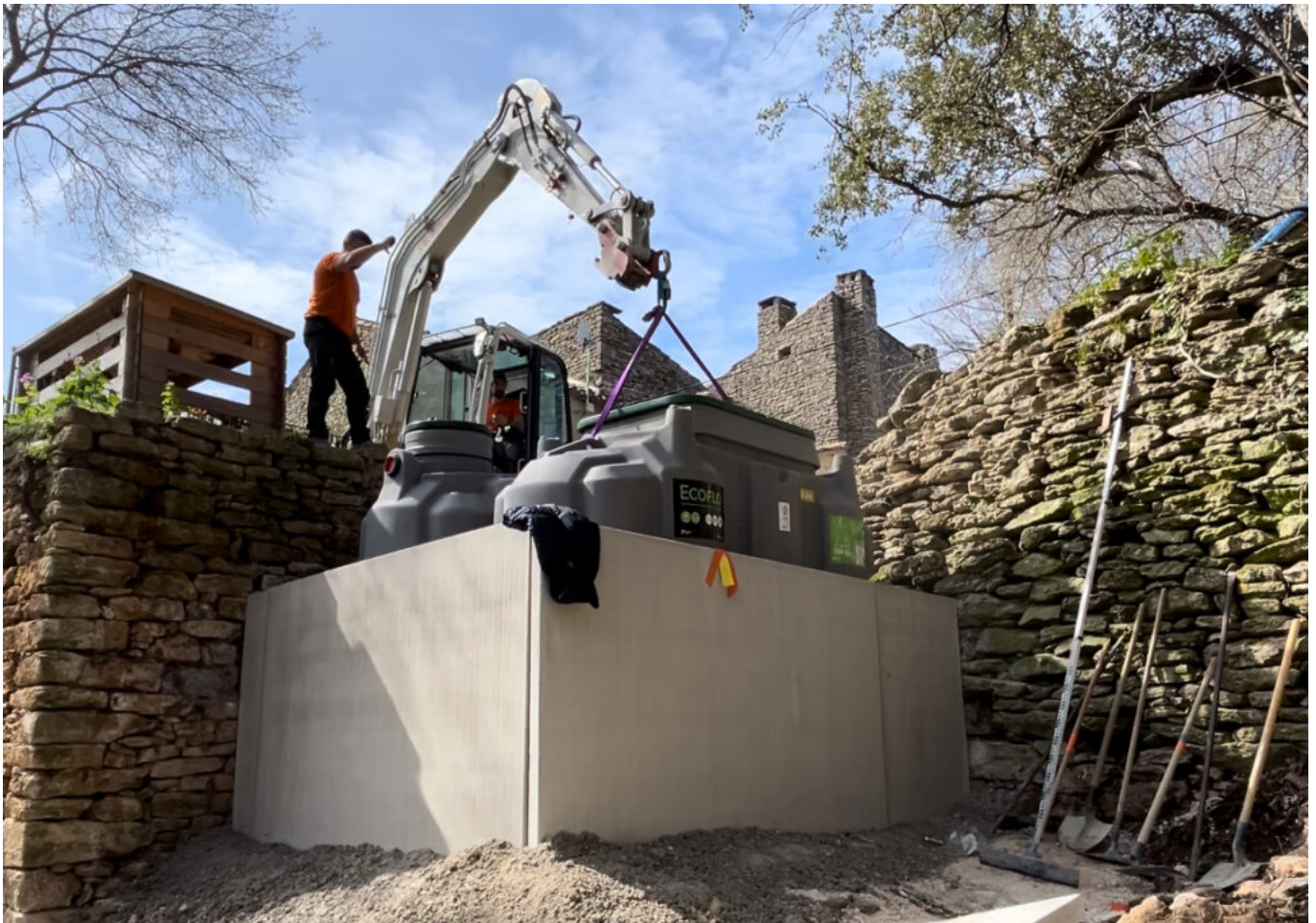
Installation d'une fausse septique Copyright GM terrassement
