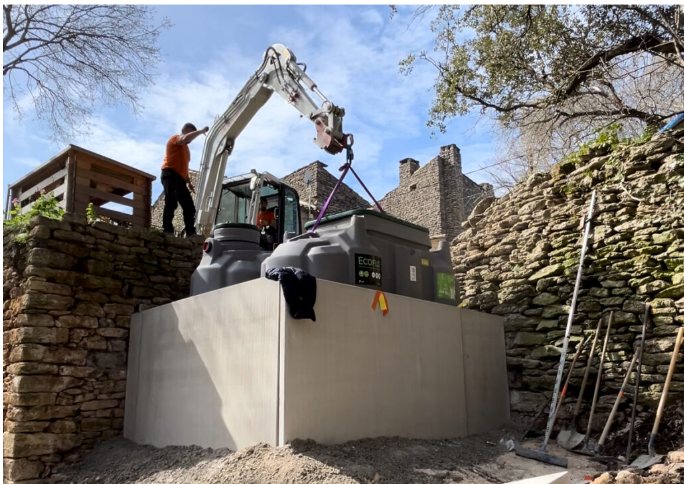
Installation d'une fausse septique Copyright GM terrassement
