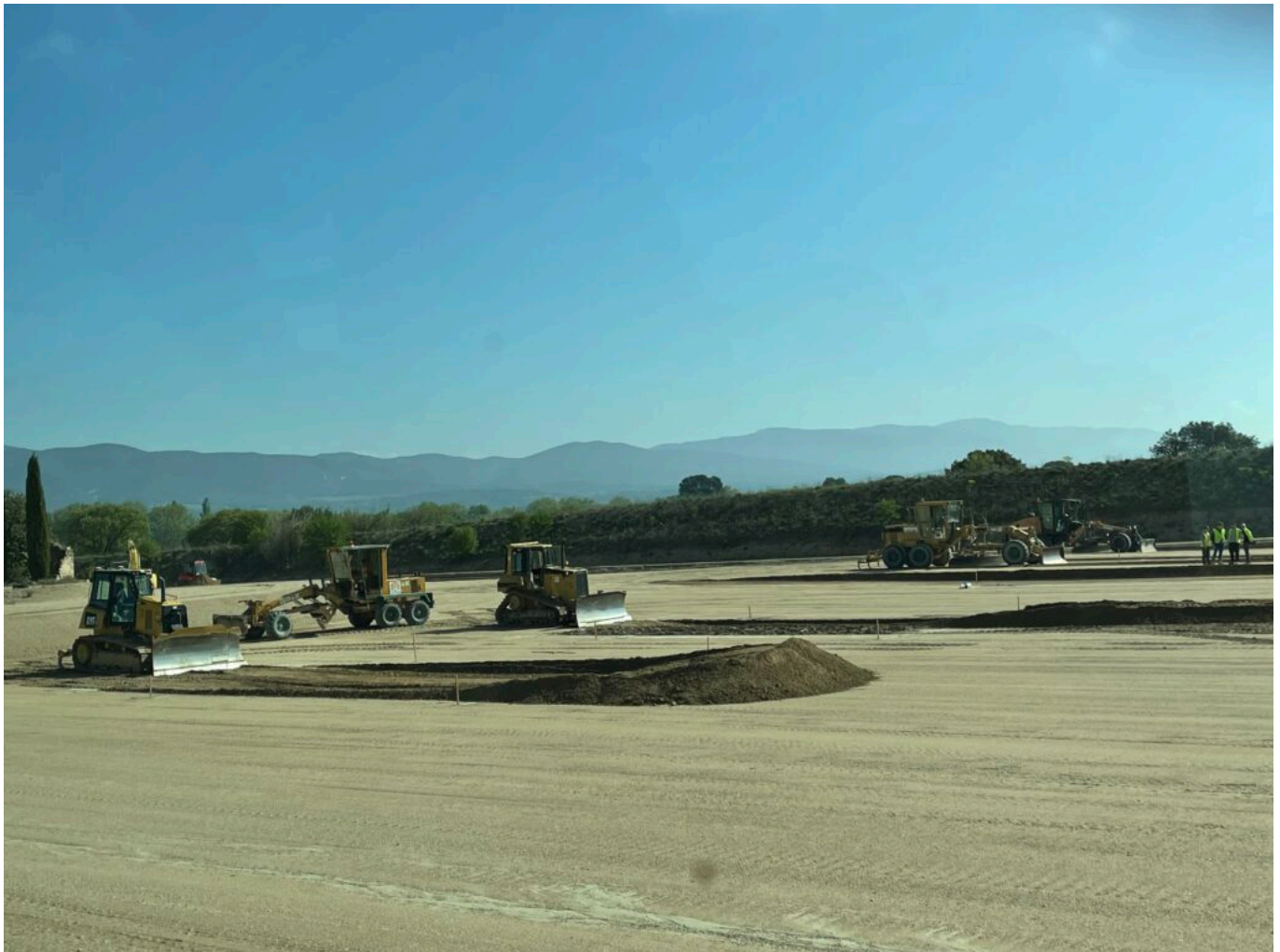
Exercices de terrassement
