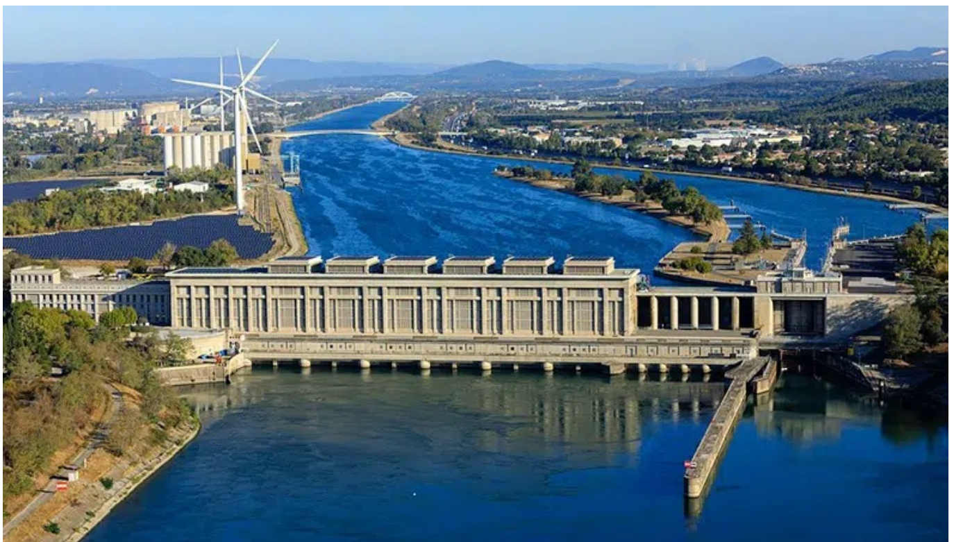
Centrale hydroélectrique de Bollène . ©CNR Bollène
